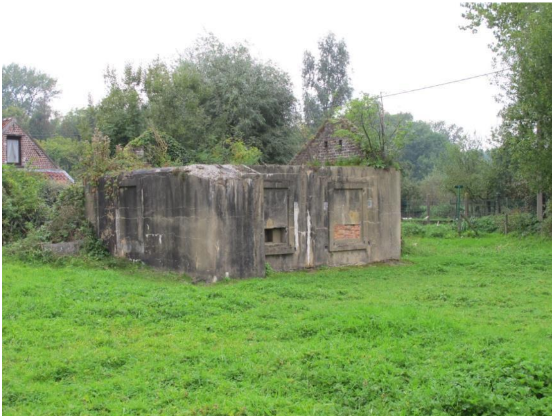
Bunker WOI, Munte Merelbeke
