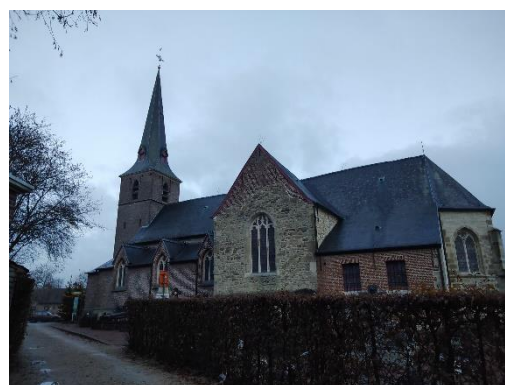
Figuur 5: de zijgevel in het zuiden
