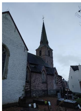
Figuur 7: de zijgevel in het noorden
