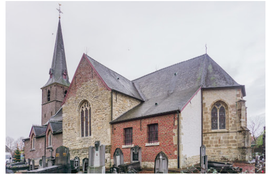
Oudste delen opgetrokken in Balegemse steen, overige delen van het natuursteenmetselwerk zijn uitgevoerd in steen van Gobertange, Franse witsteen (vermoedelijk Massengis) en veldsteen
