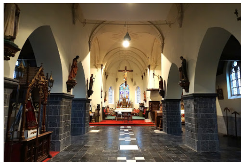
Bepleisterde gewelven, pijlers met parent, bepleisterde muren, vloer met natuurstenen tegels
