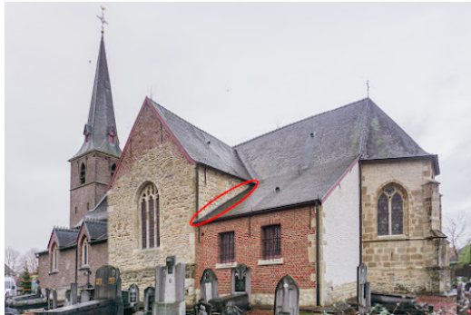
Aansluitingen met opgaand muurwerk: mortel op de overgang van het sacristiedak met de zuidzijde van het transept
