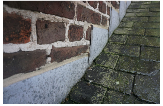
Aansluitingen met opgaand muurwerk: bijna overal loden of zinken slabben
