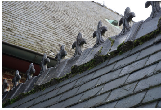
Nokken: keramische zwartgelakte nokken op de daken en kamvorsten op de dakkapellen
