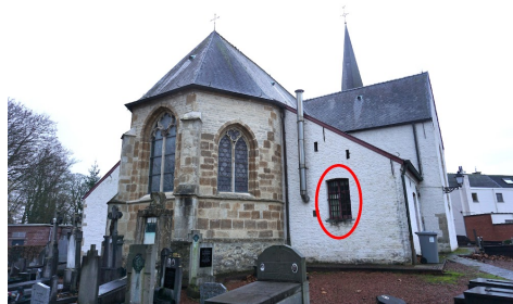
Oostelijke zijde opslagruimte: kruisokzijn met kleine roeeverdeling
