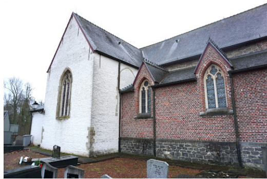
Baksteenmetselwerk op natuurstenen plint, meerdere gevels zijn wit geschilderd
