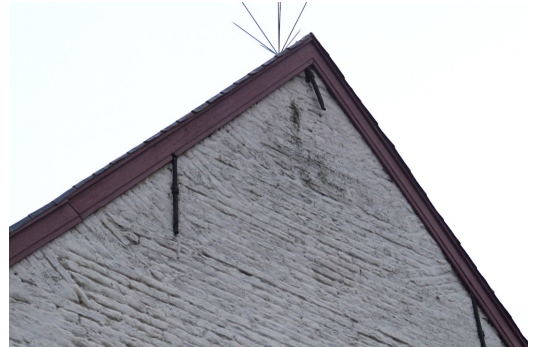
Topgevelbeëindiging: houten windveren
